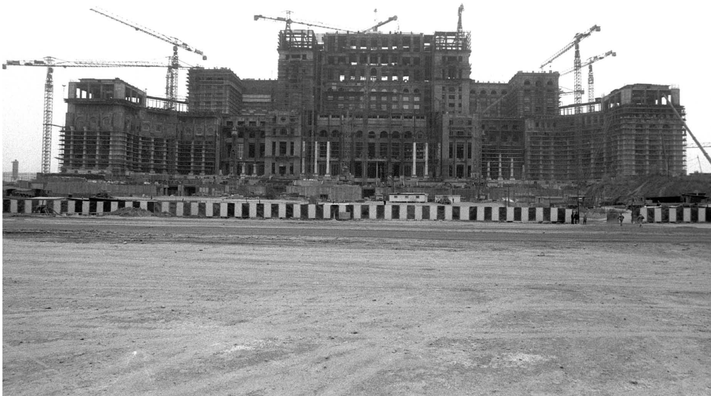
Descriere Agerpres: Șantierul de construcție al Casei Republicii (Casa Poporului).
